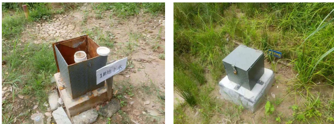
地下水监测井
