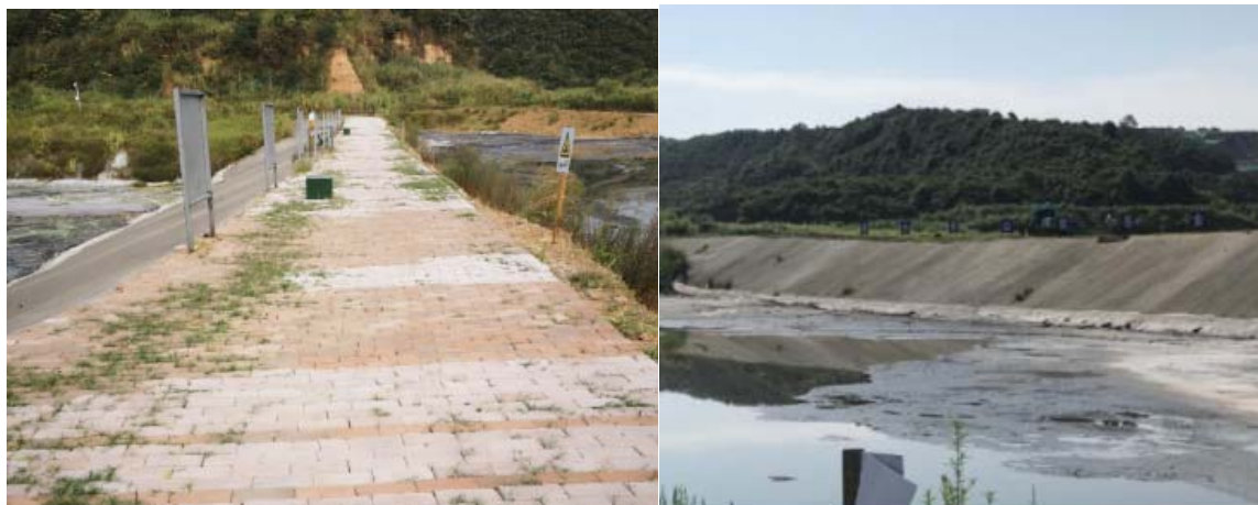
图 2-3 拦挡坝现状图
