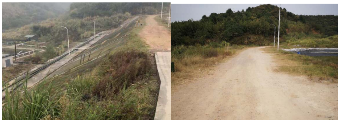
图 2-2 挡水坝现状图
